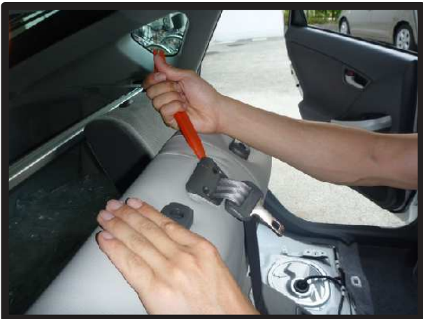
⑮シートベルトの台座を取り出します。台座のフチにヘラなどを使い生地を入れ込みます。
